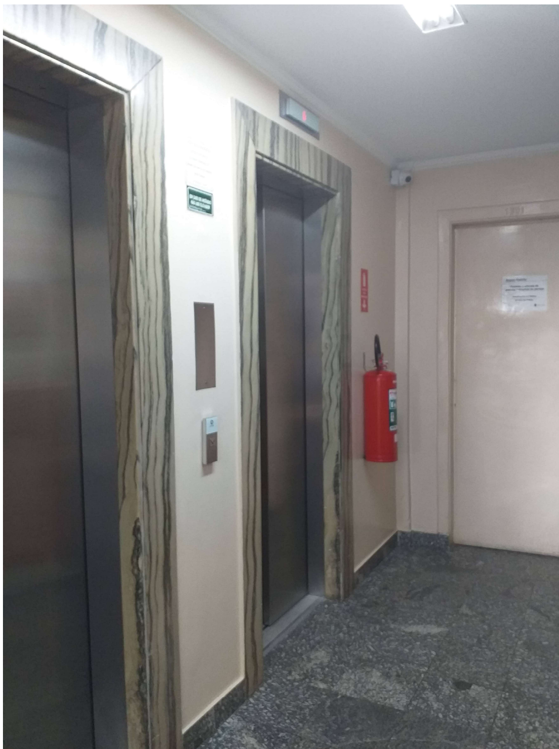
Hall dos elevadores.
