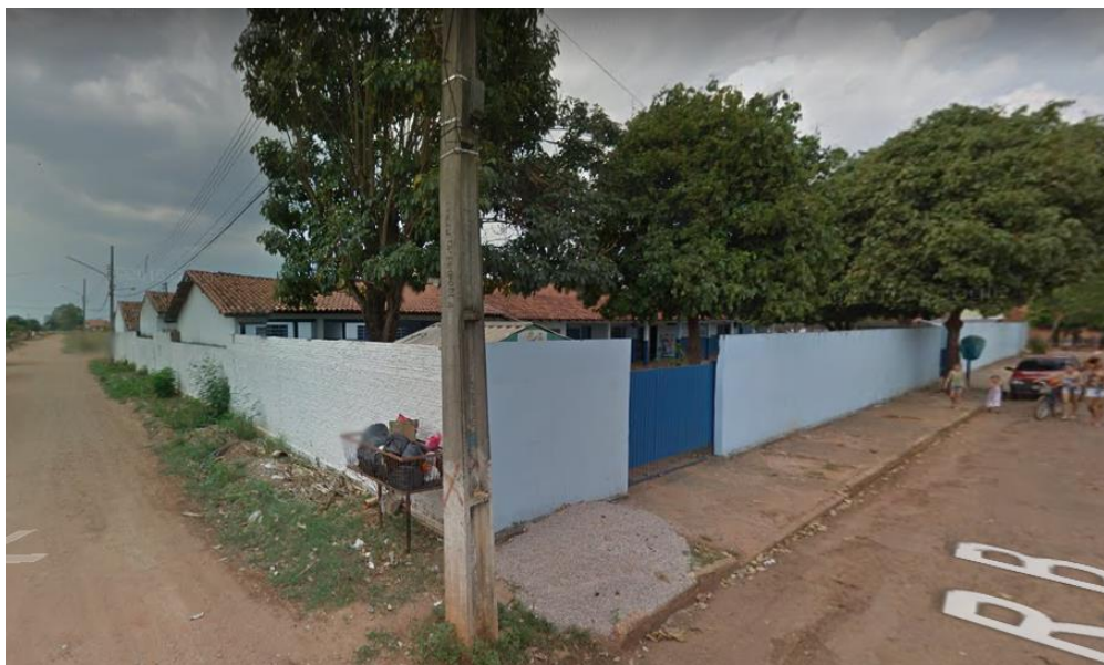
Figura 14: Vista lateral esquerda da escola urbana
