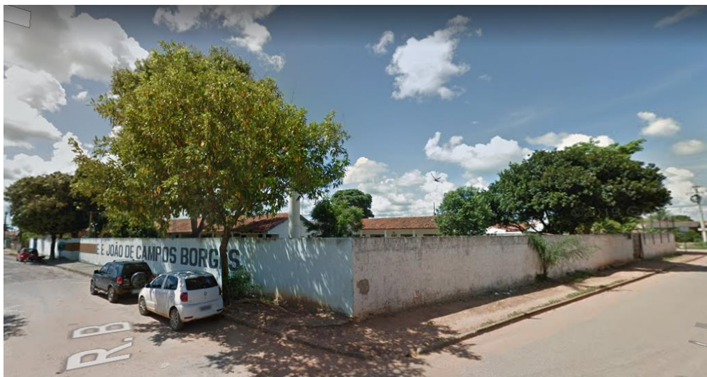
Figura 13: Vista lateral direita da escola urbana
