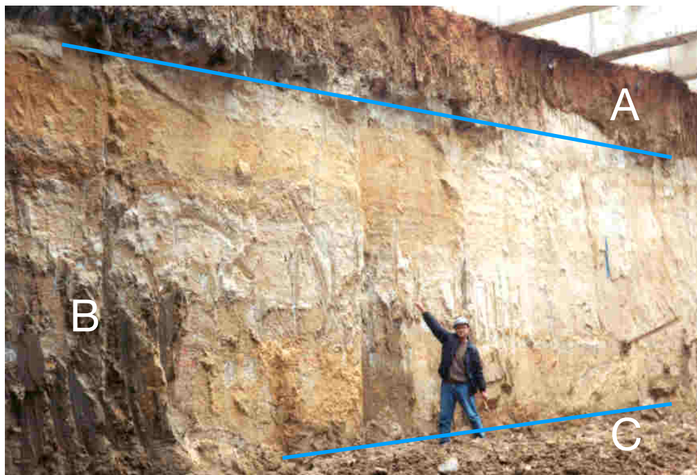
Foto 4 – Contatos das unidades Aterro(A) /Sedimentos paleógenos/neógenos (B) /Solo residual de gnaiss(C) na escavação da passagem inferior na Av. Waldemar Ferreira. Fonte: Figueiredo Ferraz
