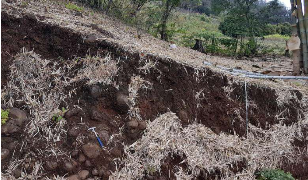
Figura 56 - Solo de alteração argiloso marrom escuro envolvendo blocos arredondados com evidente processo de esfoliação esférica.
