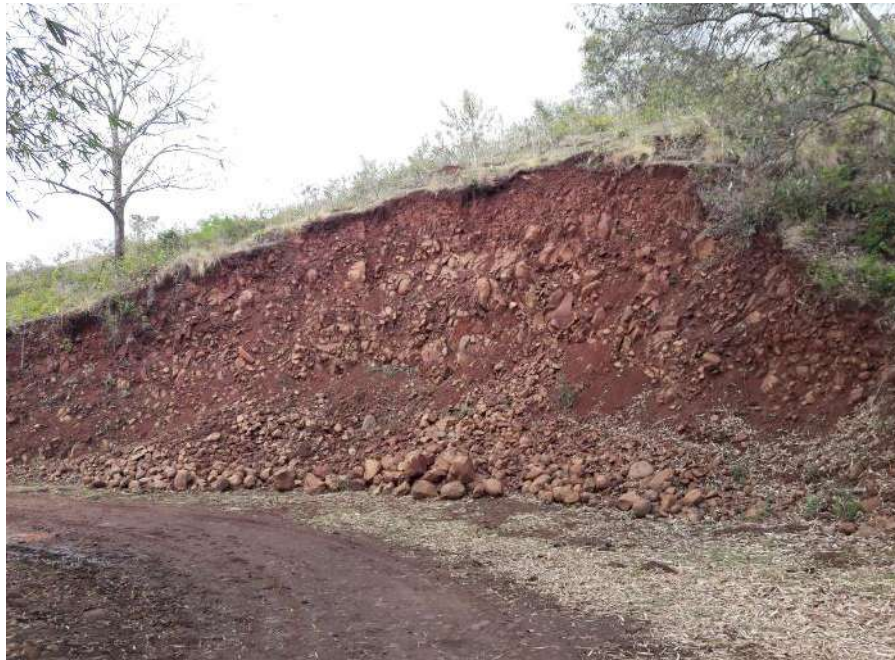
Figura 65 – Corte em estrada de acesso na poção de topo da serra, em perfil de alteração de basalto misto em solo e blocos de rocha (ponto 177; UTM 7462386.72 N/ 769483.16 E).
