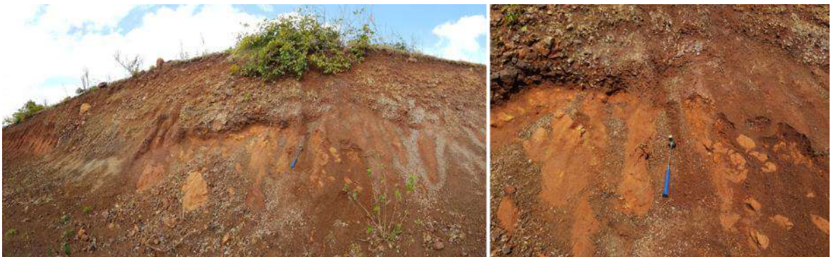
Figura 40 - Contato basalto sobre arenito apresenta contato irregular sobre arenito – contato em estrada de acesso às fazendas pelo topo da serra (ponto 185; UTM 7462188.88 N/ 769720.43 E).
