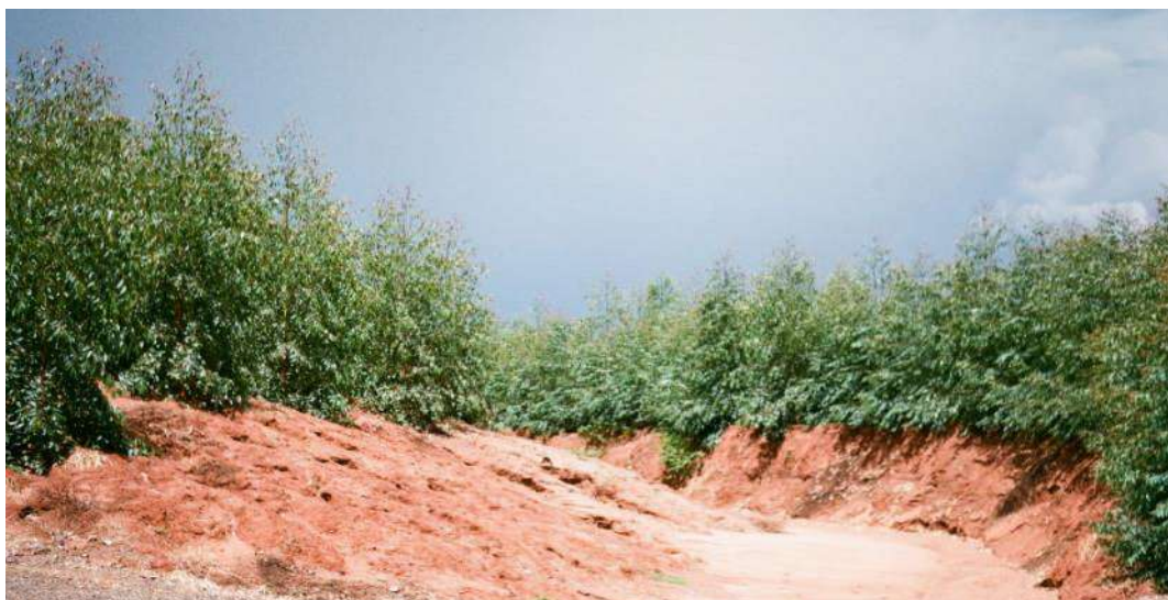
Figura 61 – Vista geral para alinhamento em arenito Botucatu exposto, com assoreamento formando canal de drenagem localizado (ponto 270; UTM 7460981.41 N/ 770839.74 E).
