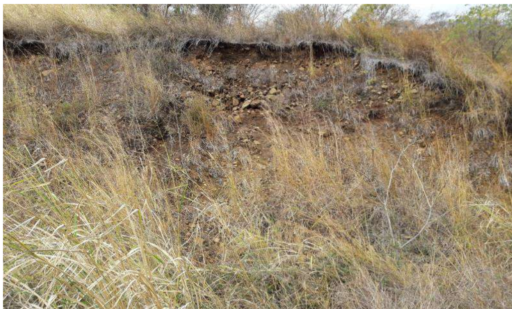
Figura 64 – Cicatriz de ruptura em perfil de alteração de rocha basáltica lateral à ferrovia Sorocabana (ponto 148; UTM 7462511.79 N/ 770469.376 E)
