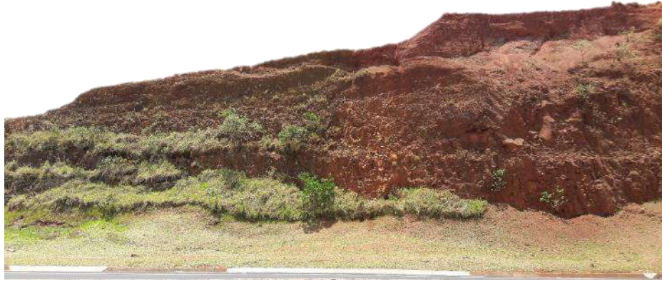
Figura 54 - Corte recuado à pista, em solo de alteração de topo de derrame basáltico, próximo ao km 239 da SP-300.
