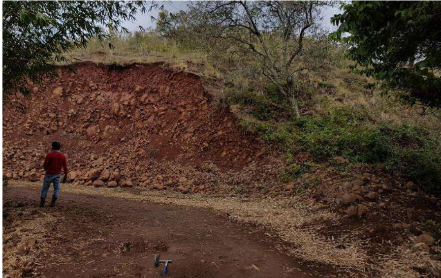
Figura 37 – Corte em perfil de alteração misto em solo residual e blocos arredondados de basalto (ponto 183; UTM 7462126.85 N/ 769593.39 E).
