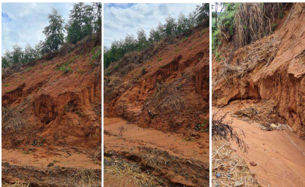
Figura 63 - Vistas para afloramento/ corte em estrada de acesso às fazendas da porção baixa a sudeste da área, em arenito e solos de alteração da Formação Botucatu com intenso processo de ravinamento e série de rupturas em solo (ponto 268; UTM 7461093.456 N/ 770863.615 E).
