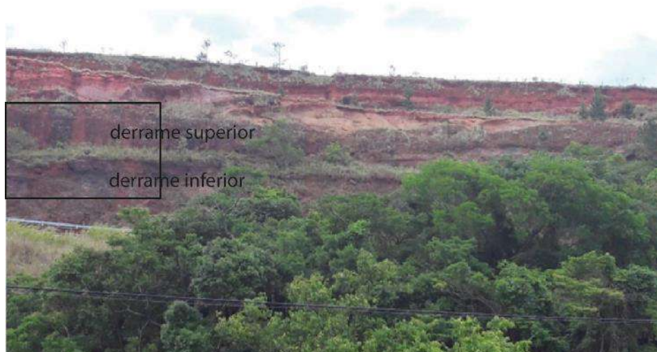
Figura 27 - Derrames sobrepostos na região A do km 239 da SP-300.
