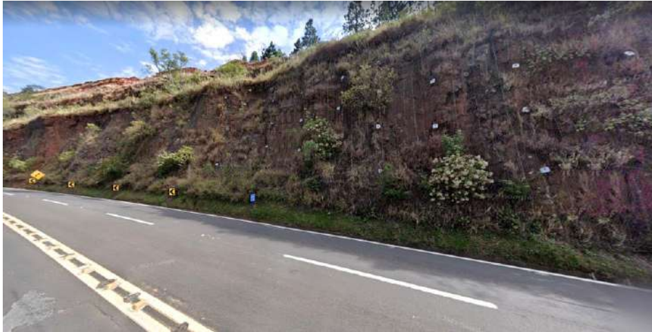
Figura 66 – Vista em perspectiva para o corte lateral à pista no km 239 apresentando tratamento com aplicação de grampos e proteção por tela; imagem obtida através do Google Street View , acesso em 09.01.23.
