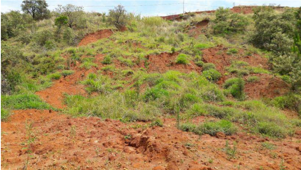
Figura 69 – Talude em arenitas eólicas abaixo de dois derrames sob nível da pista na região do km 239.
