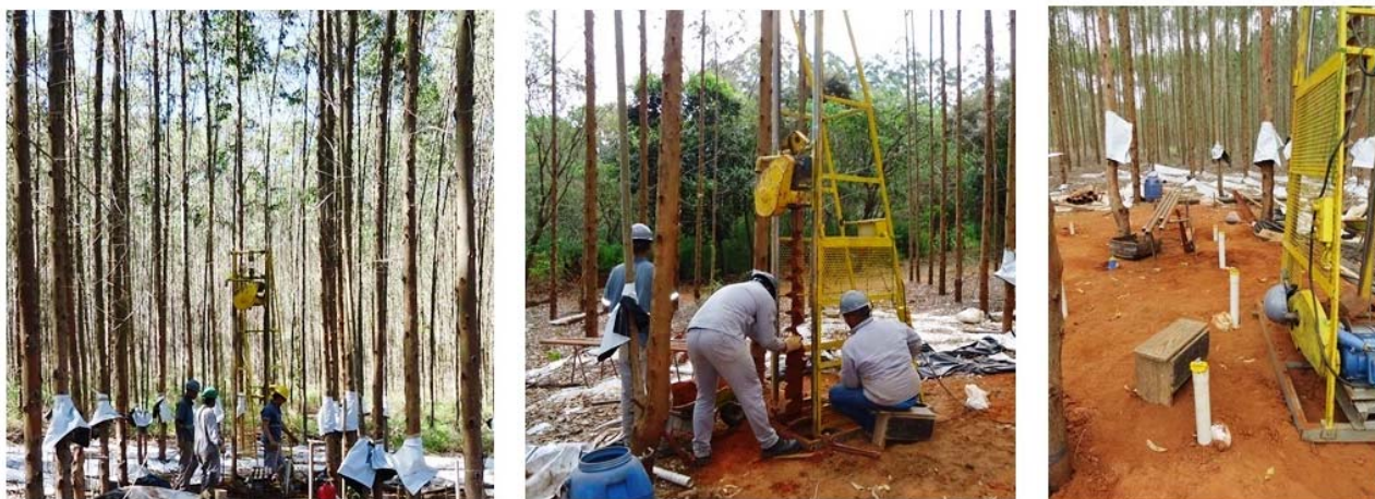
Figura 9 - Perfuração das sondagens
