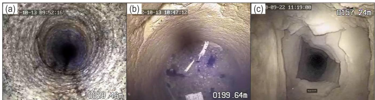
Figura 3.4: Exemplos das observações feitas ao longo das filmagens dos poços tubulares PT-A e PT-B. (a) feições litológicas, rocha do poço tubular PT-A; (b) feições construtivas, fundo do poço tubular PT-A; (c) feições estruturais, zona de quebra do poço tubular PT-B.
