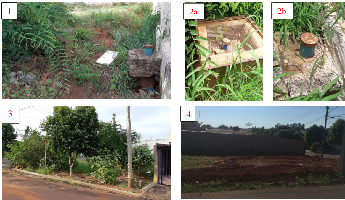
Figura 20: Instalações dos poços (foto 1); PM-1 (foto 2b) e PM-2 (foto 2a), antes (fotos 3) e depois (foto 4) do trabalho de nivelamento do terreno da Prefeitura.
