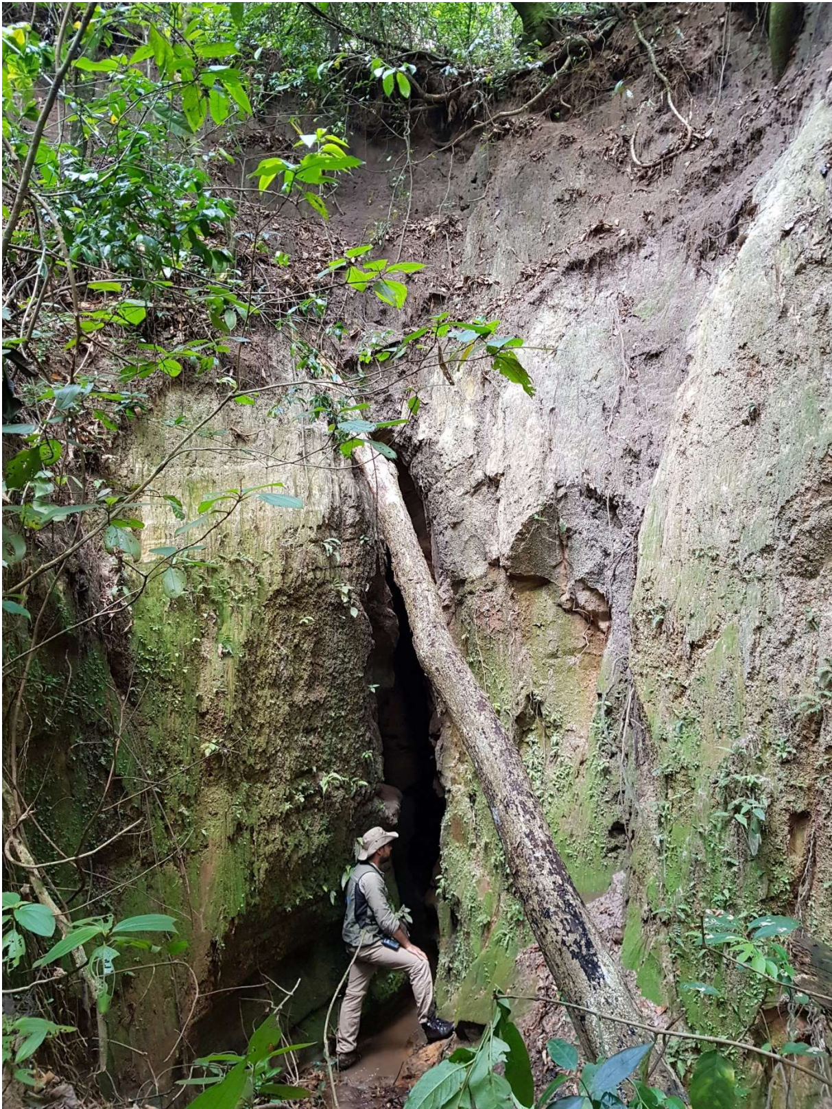
Figura 60 – Fenda principal na voçoroca a montante.
