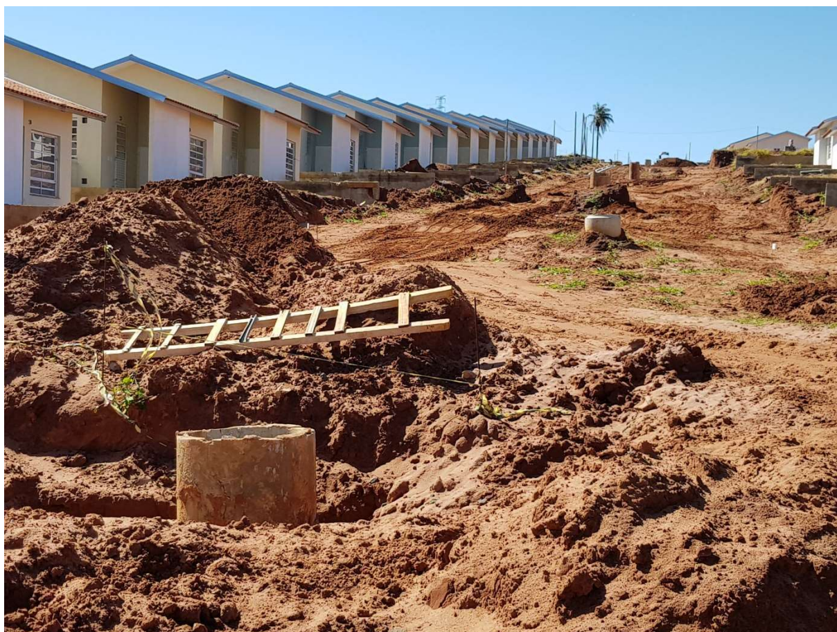
Figura 32 – Obras do Jardim Santa Maria II (ago./2021).
