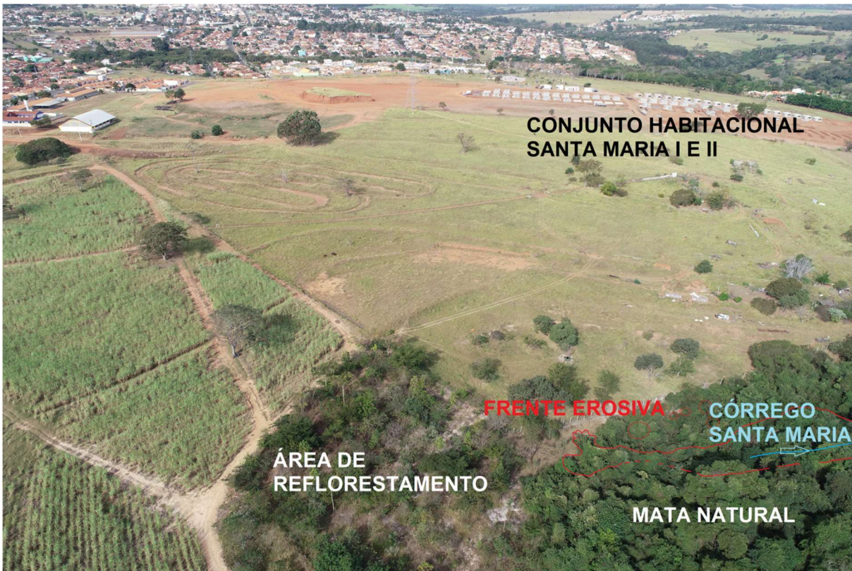
Figura 39 – Área reflorestada, com deposição de sedimentos inconsolidados bem ao lado da frente erosiva.
