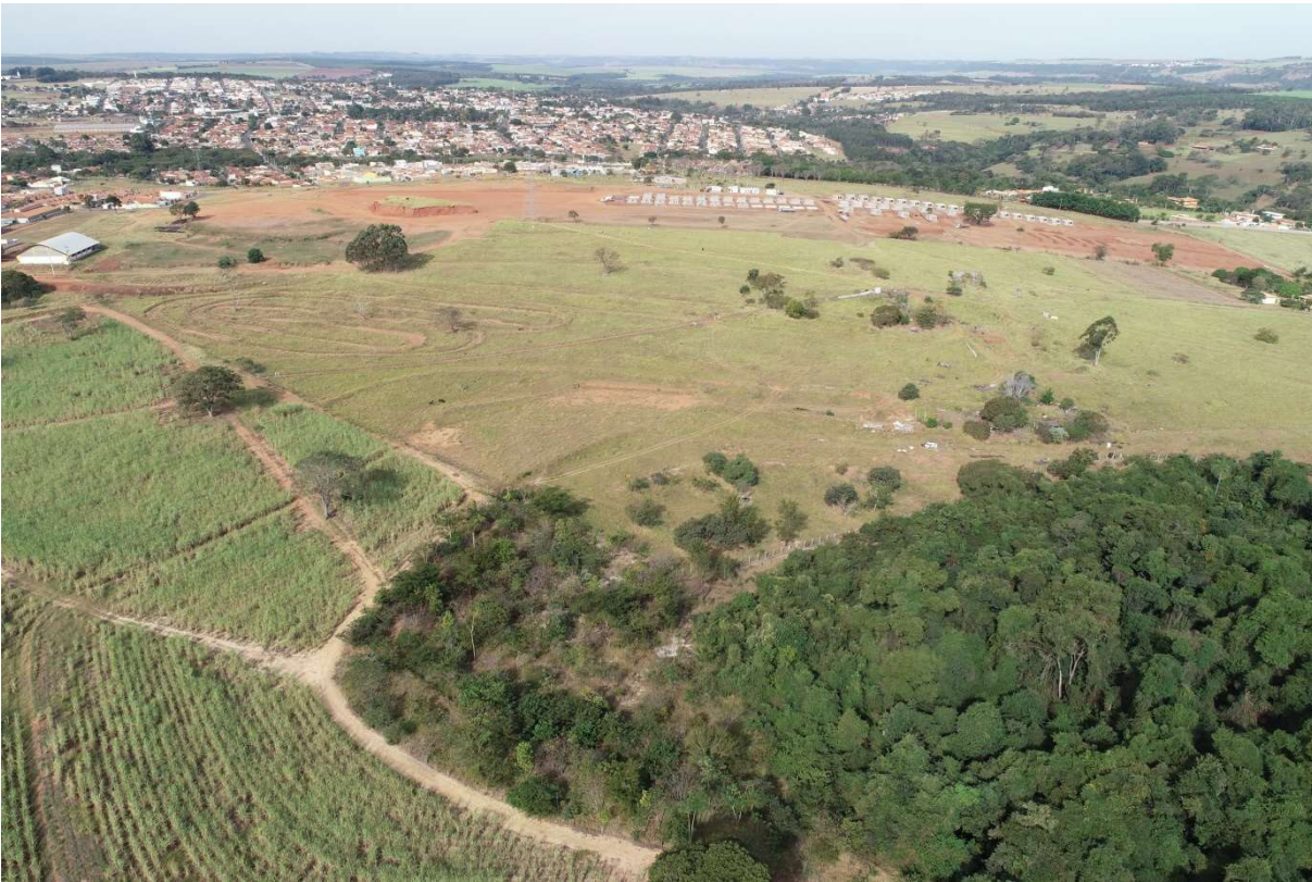
Figura 24 – Área de pesquisa (mata), área de pastagem e obras do Loteamento Santa Maria, ao fundo (jul./2019).
