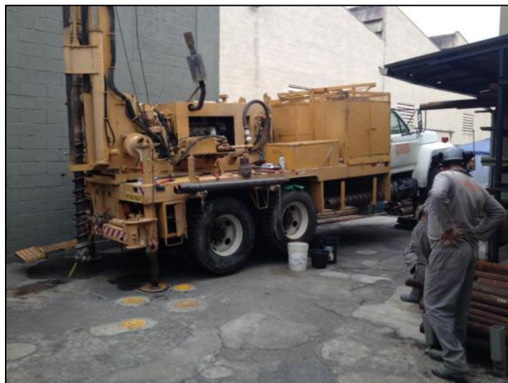
Figura 19. Sonda utilizada na perfuração
