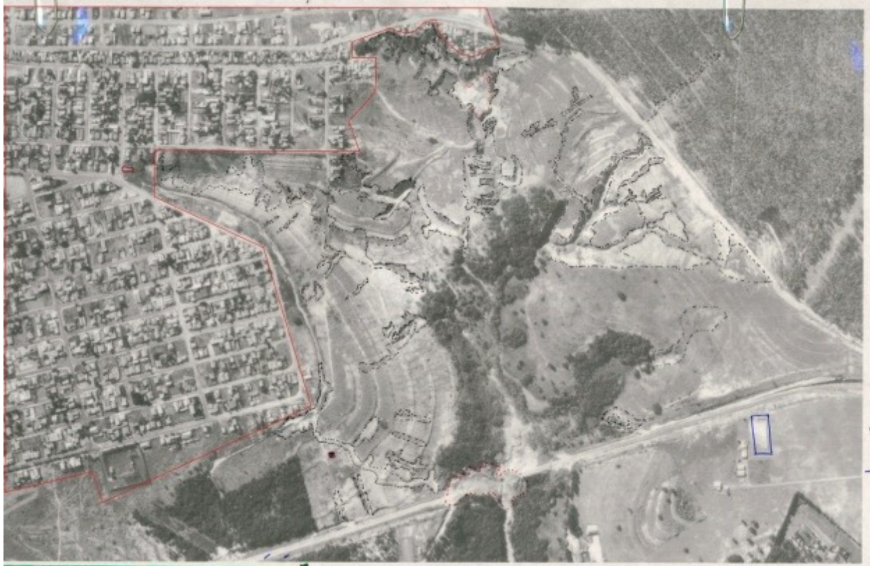
Imagem 15: Erosão no córrego do Tucum em 1995.
