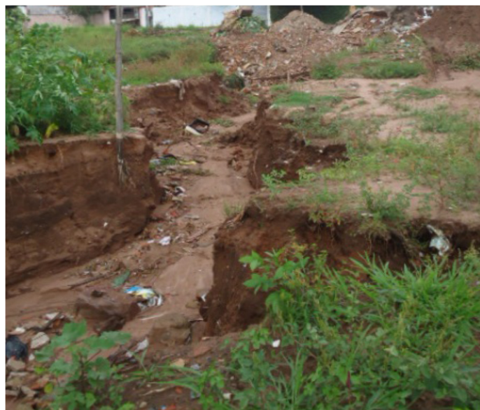
Figura 2- Visão geral de uma erosão do tipo ravina.
