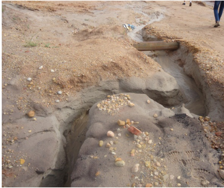
Figura 1- Vista geral de uma erosão do tipo sulco.
