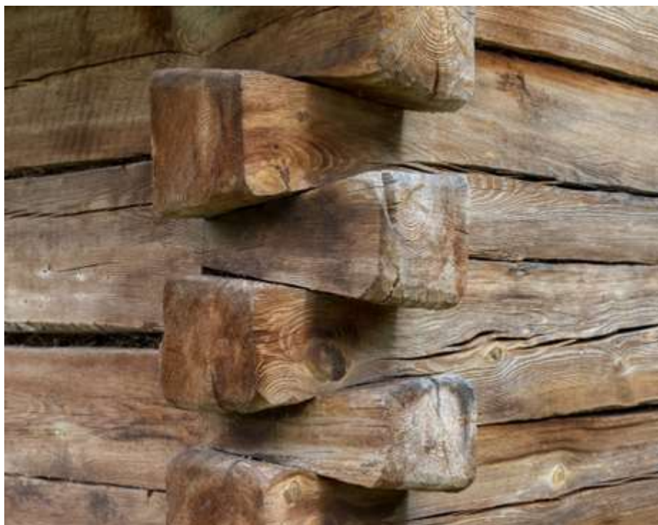
Figura 9 - Encaixe de madeira
