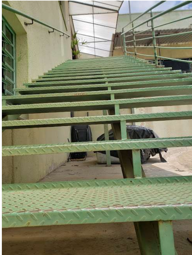
Figura 62 - A tal escada de 22 degraus no caminho para quadra
