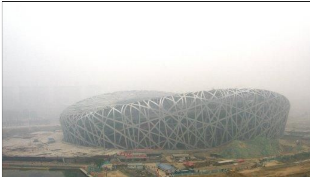
Figura 3. Construção do Estádio Nacional de Beijing, sede dos Jogos Olímpicos de 2008.
