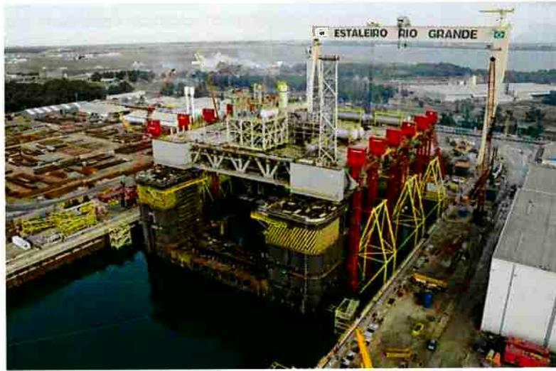
Figura 1.1: Processo de *deck mating* da plataforma P55
