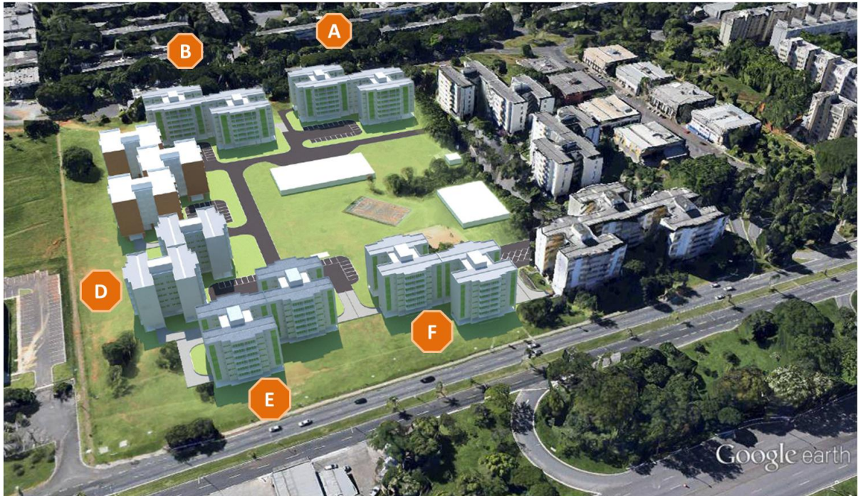
Figura 34 – Vista panorâmica da implantação do empreendimento
