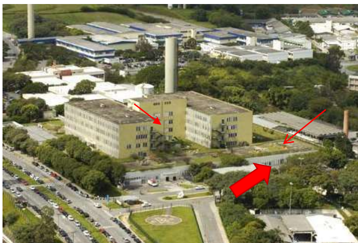
Figura 6 - Foto aérea do HU, destacando o segundo pavimento (seta larga), o jardim do terceiro pavimento (seta aberta) e o corpo em forma de “H” (seta preenchida)
