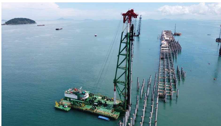
Figura 15: Cravação de estacas com bate-estacas flutuante Fonte: Swi Jetty Nusantara (2023)
