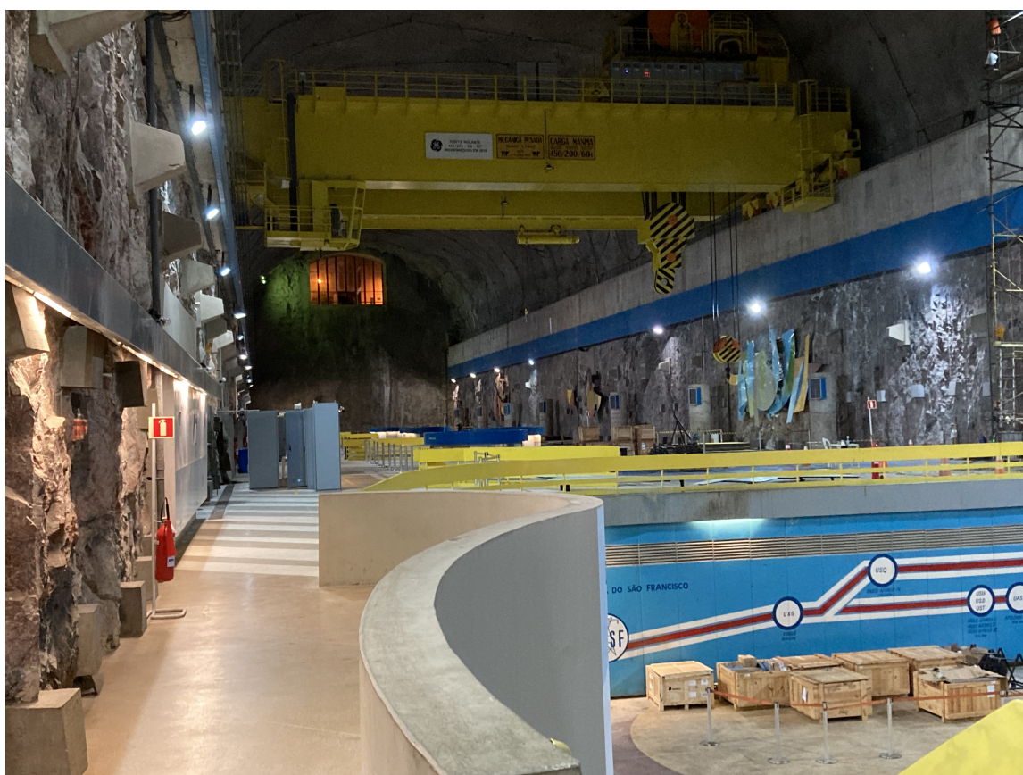
Figura 31 – Casa de força da usina, vista do piso.
