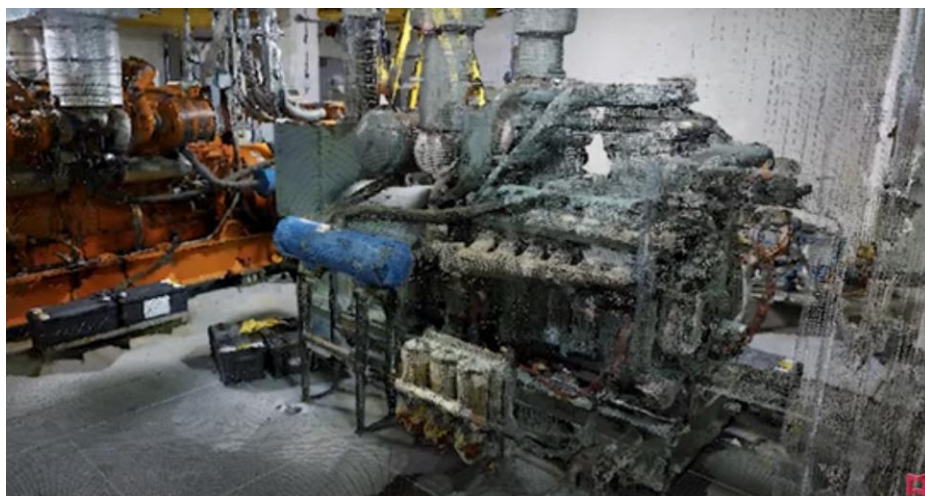
Figura 16 – Nuvem de pontos gerada a partir do processamento das fotos 360° no Matterport
