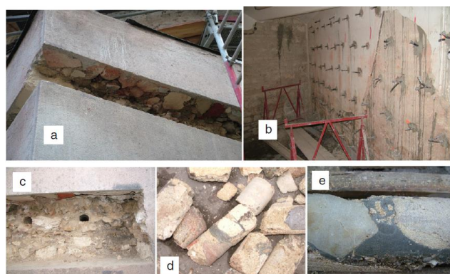
Painel de fotos: (a) parede da torre, (b) tubos de injeção de cimento, (c) furos na parede para injeção, (d) material retirado para injeção e (e) seção da parede com materiais originais e com cimento injetado. Fonte: Kanli, 2015.
