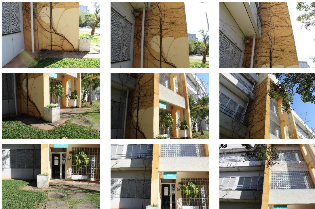
Figura 67 – Fotogrametria terrestre – Portal de entrada do IME – Amostra de fotos capturadas em campo.
