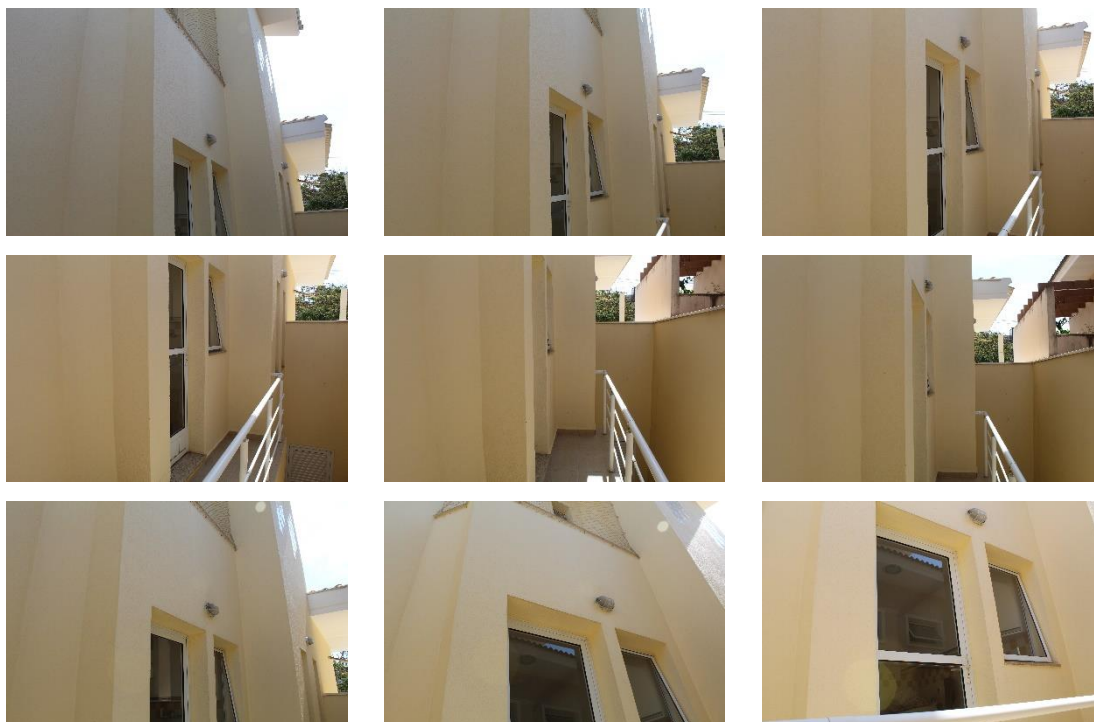
Figura 30 – Fotogrametria terrestre – Casa em Sorocaba – Parede externa – Amostra de fotos capturadas em campo.
