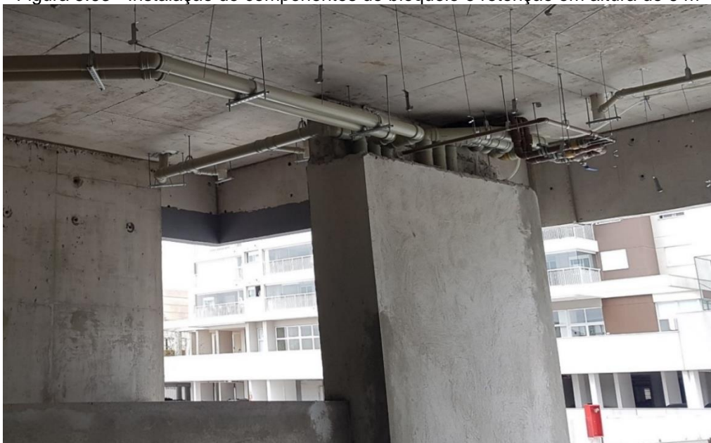
Figura 5.63 - Instalação de componentes de bloqueio e retenção em altura de 6 m
