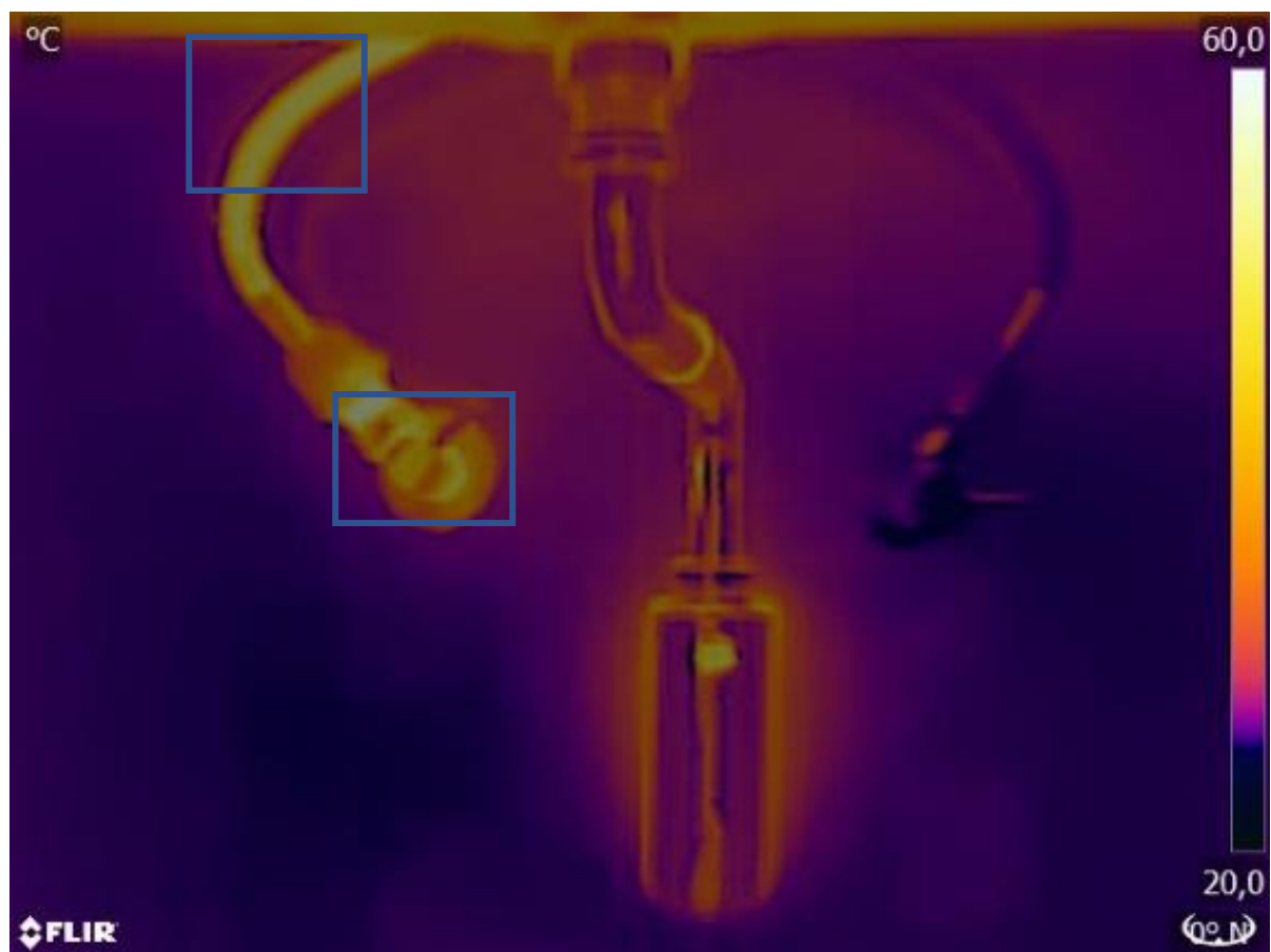
Figura 5.17 - Verificação da temperatura das superfícies da conexão do misturador para lavatório com câmera termográfica - vista geral
