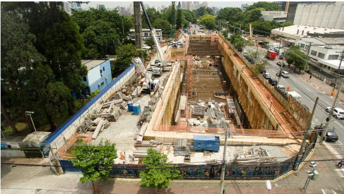
Figura 33 – Estação AACD, linha 5-Lilás: Lajes intermediárias em execução
