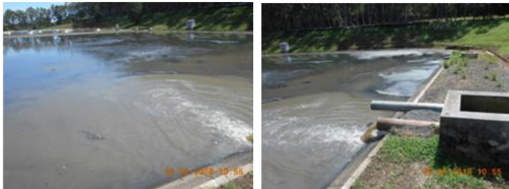
Figura 8 – Fotos de lagoa anaeróbia na cidade de Itatinga-SP Fonte: autoria própria
