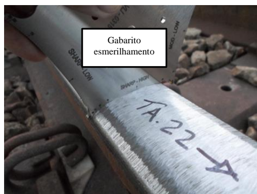
Figura 26 - Trilho alto de curva após esmerilhamento e conferência da qualidade do esmerilhamento de forma visual (remoção de defeitos superficiais) e usando o gabarito para verificação do perfil. Fonte: do autor.
