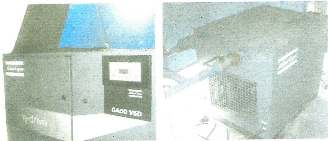
Figura 3.5 – Compressor e secador de ar
