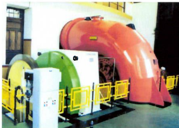
Figura 4.8. Turbina Francis com Caixa Espiral. [10]
