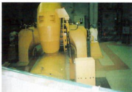
Figura 3.26. PCH Padre Carlos Equipada com Turbinas Francis Dupla.
