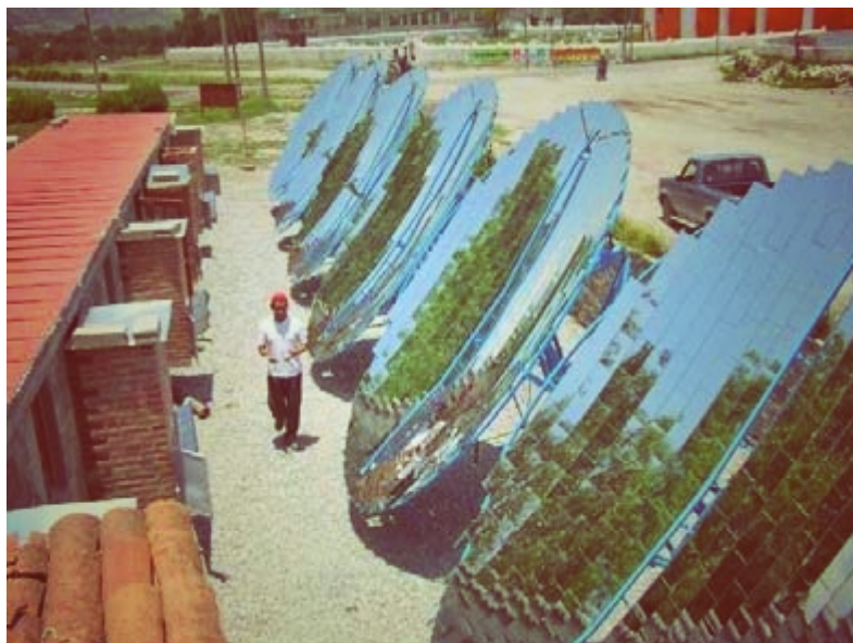
Figura 2.10 – Cozinha solar com vários concentradores solares Scheffler. Schapers (2009).
