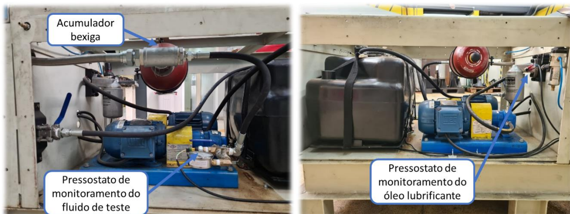
Figura 19 – Acumulador tipo bexiga e pressostatos de monitoramento
