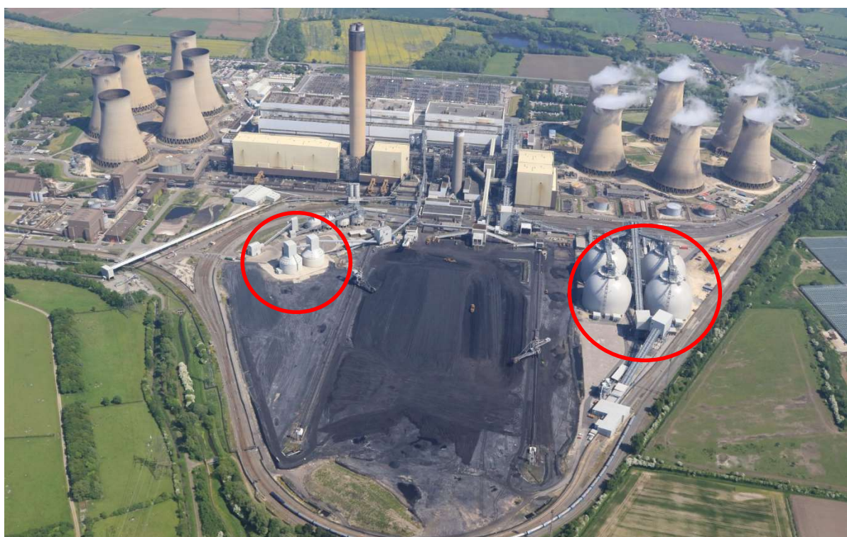
Figura 2-4 - Vista aérea da usina termelétrica Drax, em North Yorkshire, na Inglaterra. São circulos em vermelho os silos de armazenamento de pellets de madeira, coexistindo com o pátio de carvão. Fonte: DRAX (2018).
