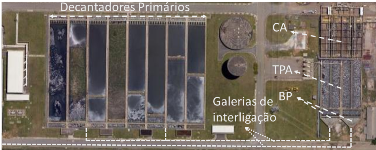
Figura 22 – Vista aérea esquemática da ligação entre os Bicos de Pato e os Decantadores Primários do módulo 1.
