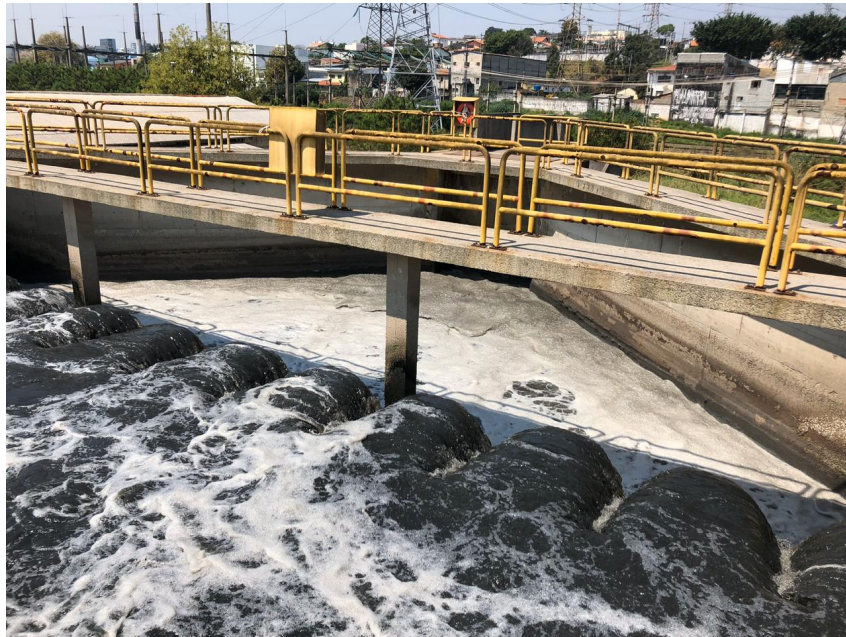
Figura 20 – Vista de montante de um dos vertedores de um dos Bicos de Pato.
