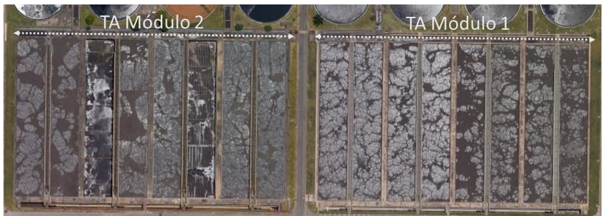
Figura 25 – Vista aérea dos Tanques de aeração.
