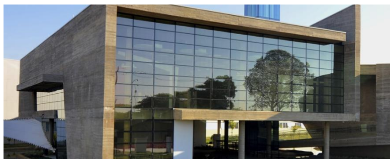
Figura 4 – Fachada do Centro de P&D da Saint-Gobain com vidros eletrocromicos. Fonte: SAINT-GOBAIN, 2021.
