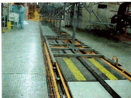
Figura 2.2 – Vista geral da linha de carga.
