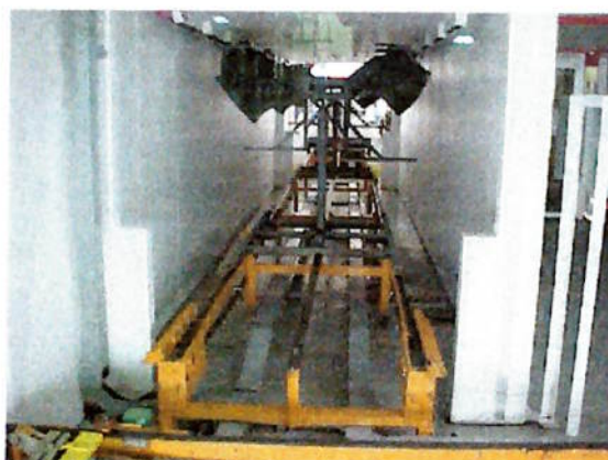
Figura 2.57 – Linha do túnel de resfriamento.
