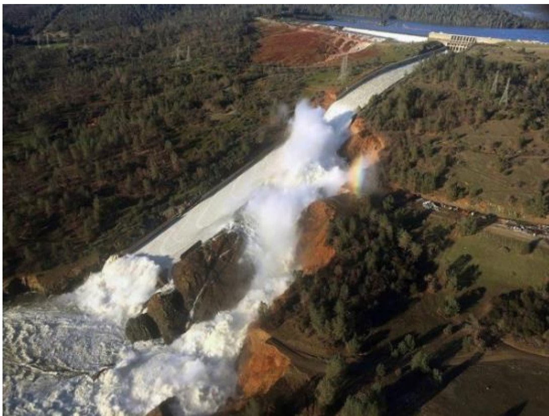
Foto 2.2 – Vertedouro da Barragem de Oroville (EUA) com o escoamento passando por fora do canal rápido, gerando danos graves ao seu entorno. Fonte: https://www.gh Engenharia.com.br
