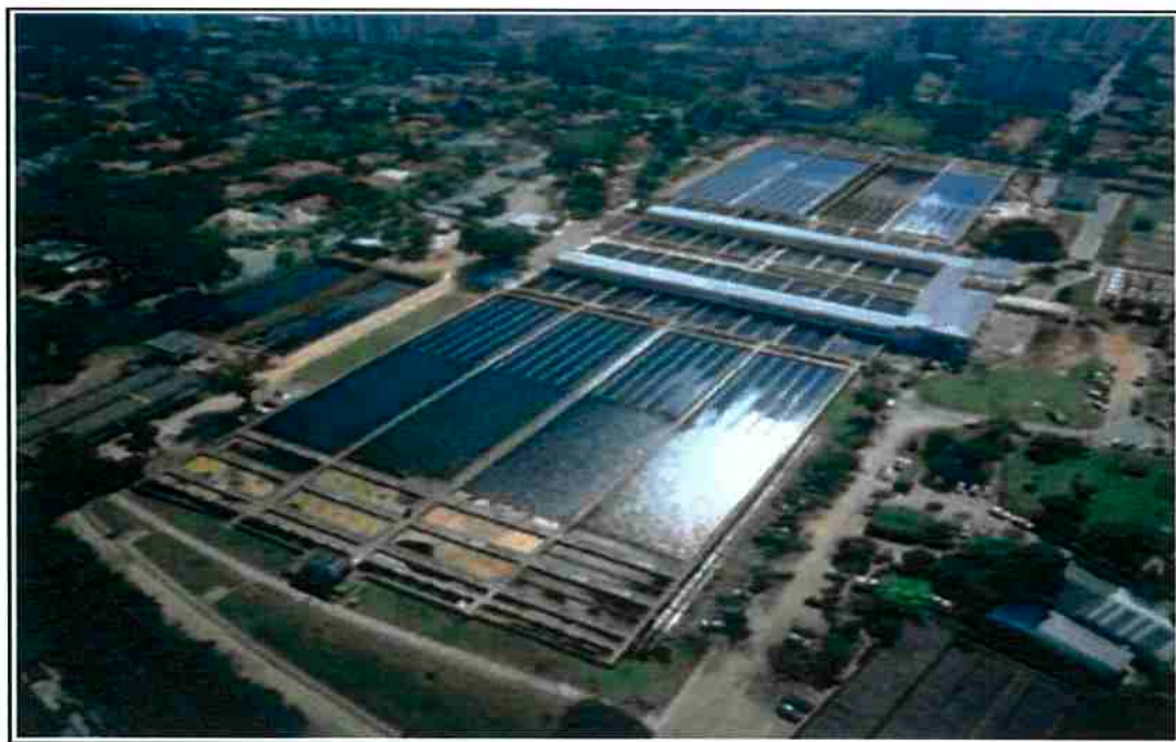
Figura 4.9 – Fotografia aérea da Estação de Tratamento de Água Alto da Boa Vista (SABESP, 1998)
