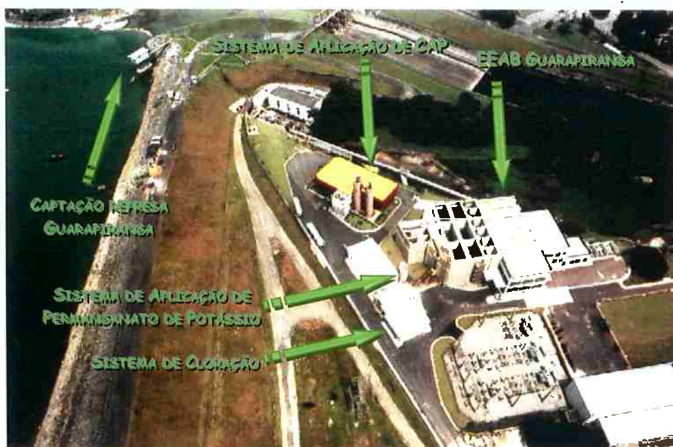
Figura 4.10 – Processos unitários existentes no Complexo Guarapiranga (FERNANDES, 2006)
