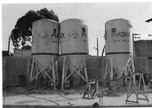
Figura 5.3 – Silos de argamassas (um para cada torre e um para térreo e subsolo) – Obra SP 30.
