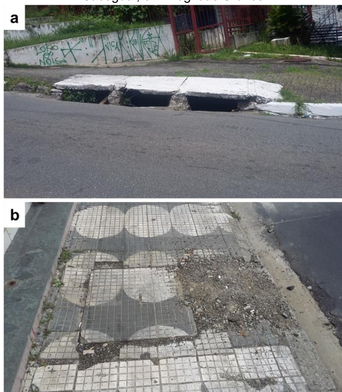
Figura 46 - Exemplo de contornos de elementos com danos graves pertencentes às redes de (a) drenagem, na R. Dr. Franco da Rocha, em Franco da Rocha, e de (b) esgoto, na R. Barão de Jaceguai, em Mogi das Cruzes
