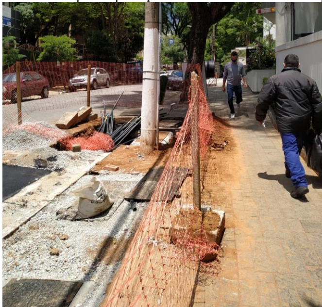
Figura 8 – Exemplo de proteção do canteiro da obra na calçada
