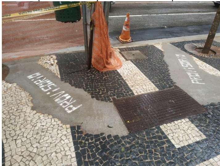
Figura 10 – Exemplo de identificação do revestimento provisório em calçada
