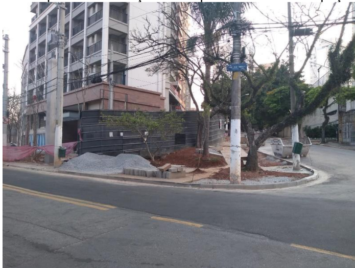
Figura 12 - Exemplo de intervenção inadequada de obra no espaço da calçada
