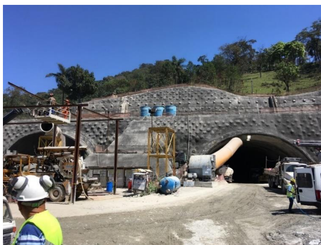
Figura 4 - Emboque do túnel RODOANEL - Lote 5.
