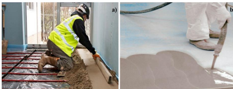
Figura 1 - (a) Contrapiso cimentício semi-seco tradicional (b) Argamassa autonivelante.
