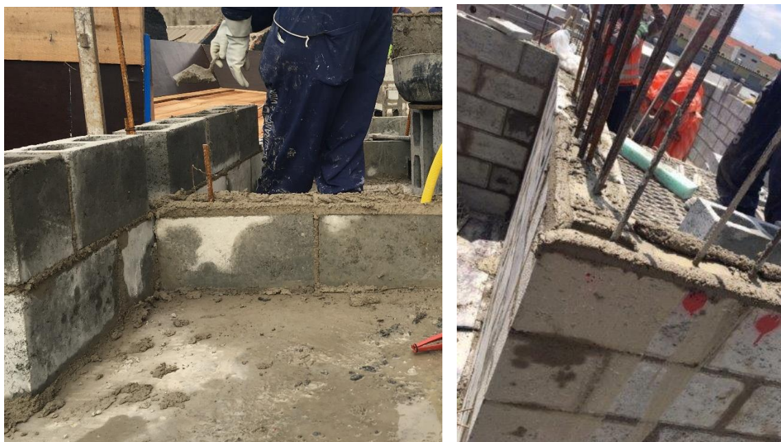
Figura 21: Assentamento de alvenaria estrutural executada com colher de pedreiro e argamassa estabilizada fornecida pela Supermix. Fotos tiradas pela autora durante coleta de dados no canteiro.
