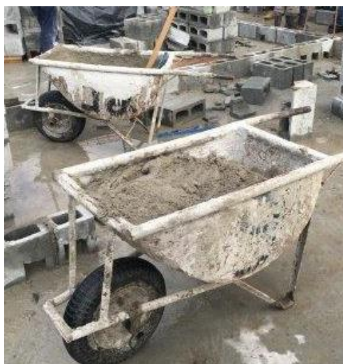
Figura 7: Transporte horizontal da argamassa realizada com carrinho de mão no canteiro. Fotos tiradas pela autora durante coleta de dados.
