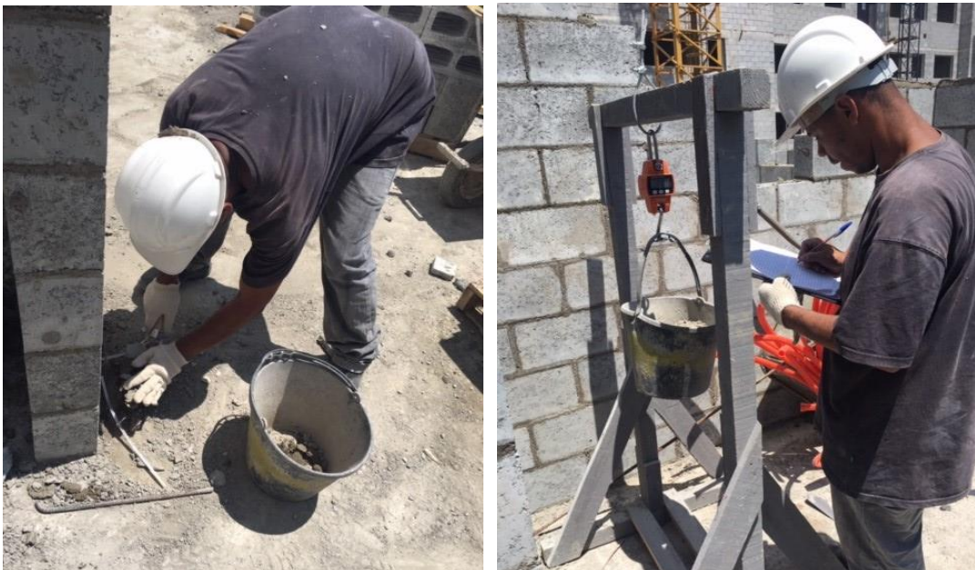
Figura 10: Processo de quantificar o resíduo sólido: a esquerda coleta da argamassa caída no chão durante o processo de assentamento e transporte da argamassa, e a esquerda pesagem com balança suspensa (precisão de 0.01 kg). Fotos tiradas pela autora durante coleta de dados na obra.
