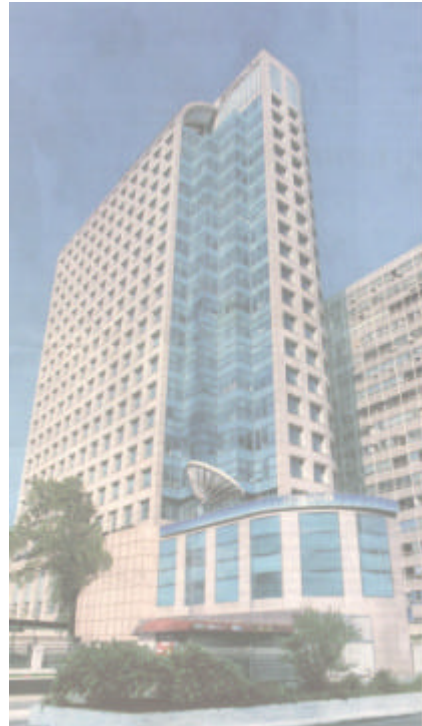
Edifício Citibank (década de 80)
