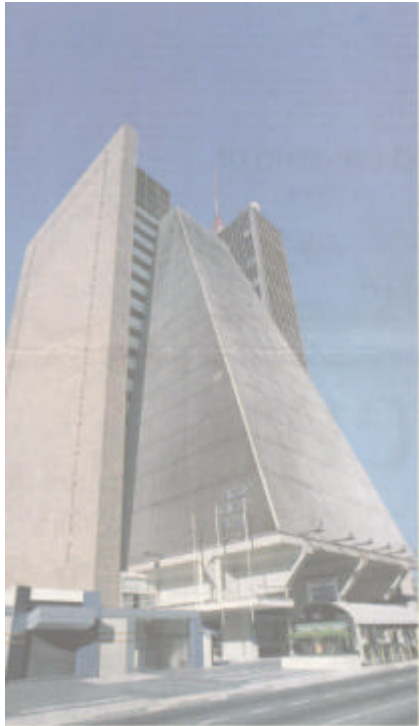
Edifício FIESP (década de 70)
