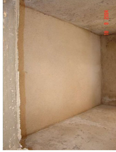
Figura 115: Revestimento de argamassa aplicado no teto de asilo da cidade de Socorro/SP, com areia reciclada lavada da Fase 5 desta pesquisa.
