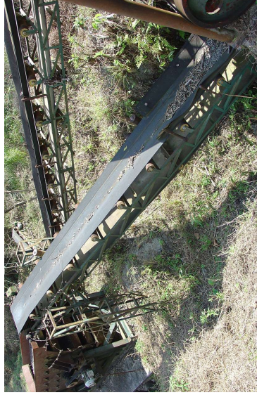
Figura 23: Transportadores de correia (foto do autor).
