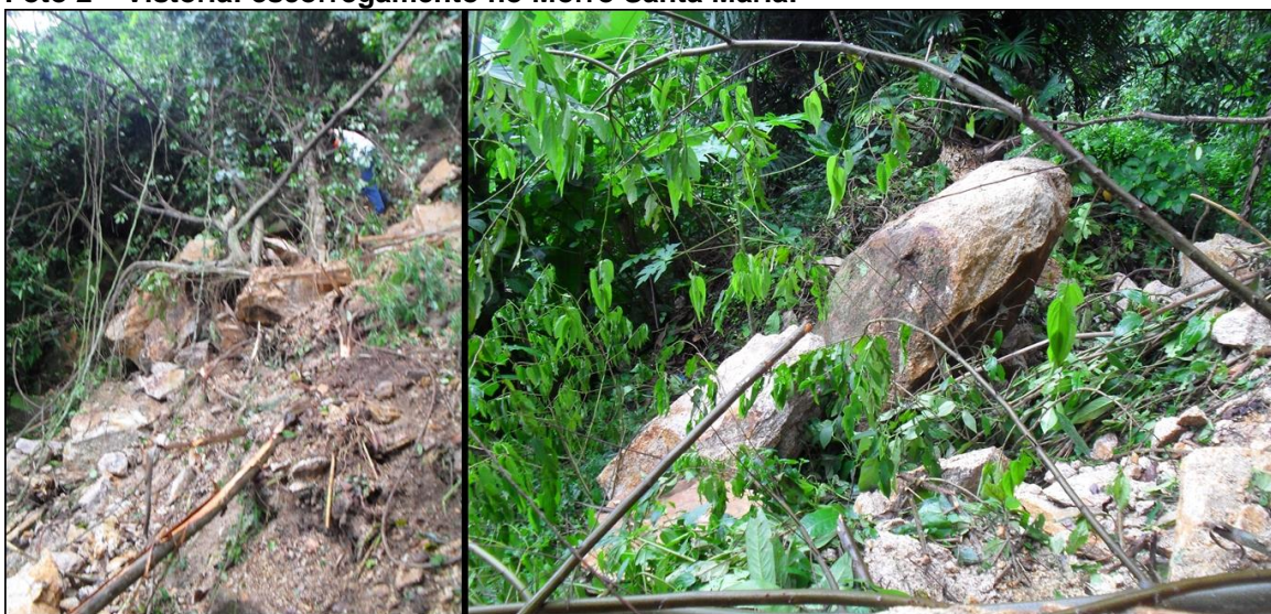
Foto 2 – Vitoria: escorregamento no Morro Santa Maria.
