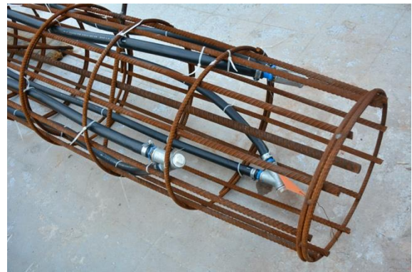
Figura 2 - Conexões triplas de tubos U
