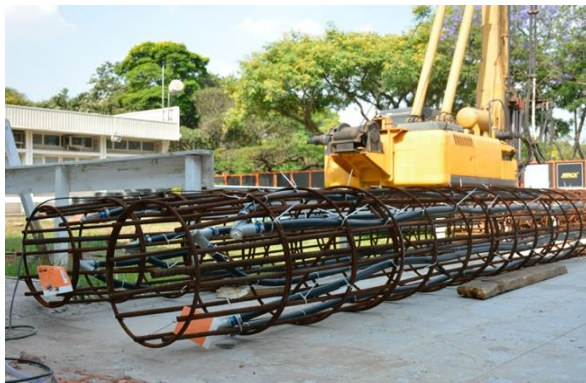
Figura 1 - Armadura de reforço com tubos PEAD
