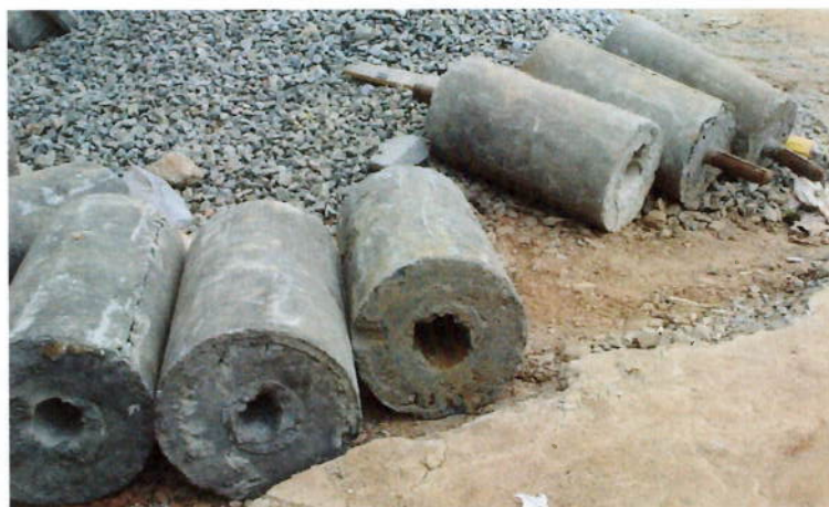
Foto 5.2.3 – Detalhe dos segmentos de concreto com e sem a barra de aço “grauteada”.
