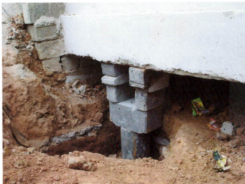
Foto 5.2.4 – Detalhe do encunhamento da estaca, após a retirada do macaco hidráulico.
