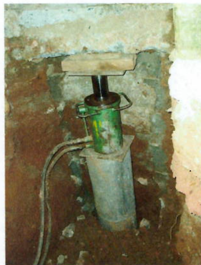
Foto 5.2.1 – Macaco hidráulico mantendo estaca sob carga.
