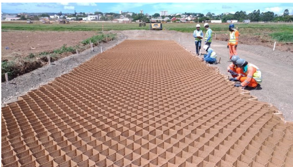
Figura 9. Instalação da geocélula no trecho experimental.
