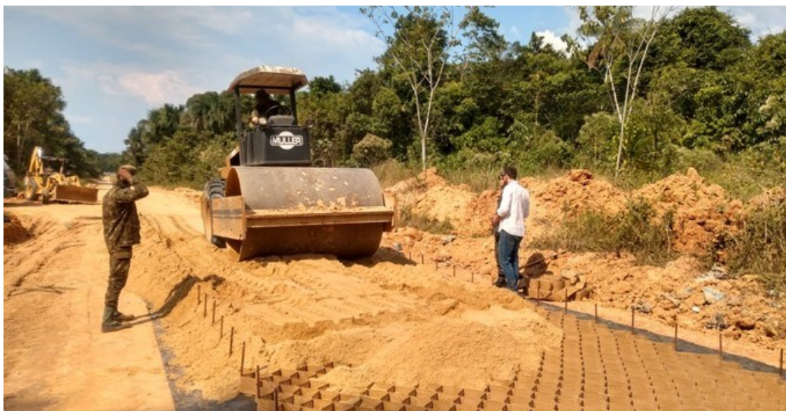
Figura 4. Emprego de geocélula para vias não pavimentadas na região amazônica.
