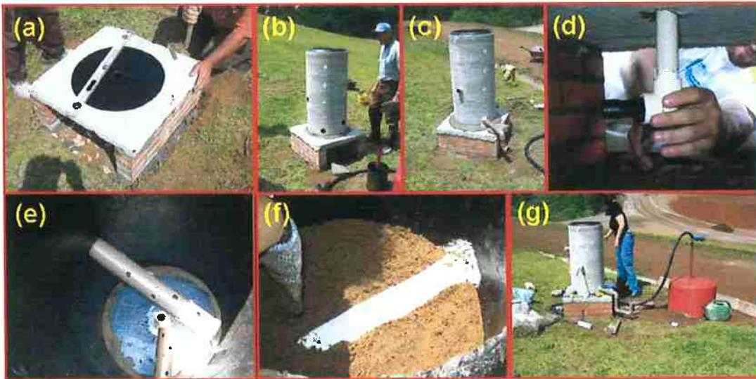
Figura 8.3 – Detalhes da montagem do biofiltro.
