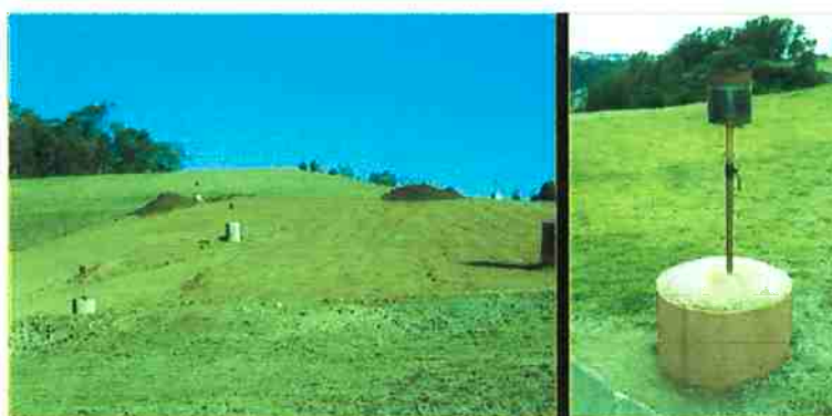
Figura 8.2 – Vista de parte do aterro de São Giacomo e tubo de drenagem usado no biofiltro.
