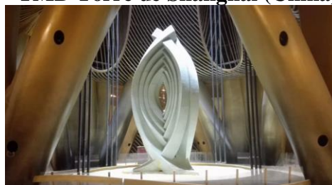
Figura 2 - TMD Torre de Shanghai (China) 1000 ton.
