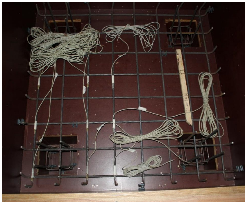
Figura 7.12 - Instrumentação da armadura tipo A1D, do bloco N1B45A1D (1,2 x 1,2 x 0,55m)
