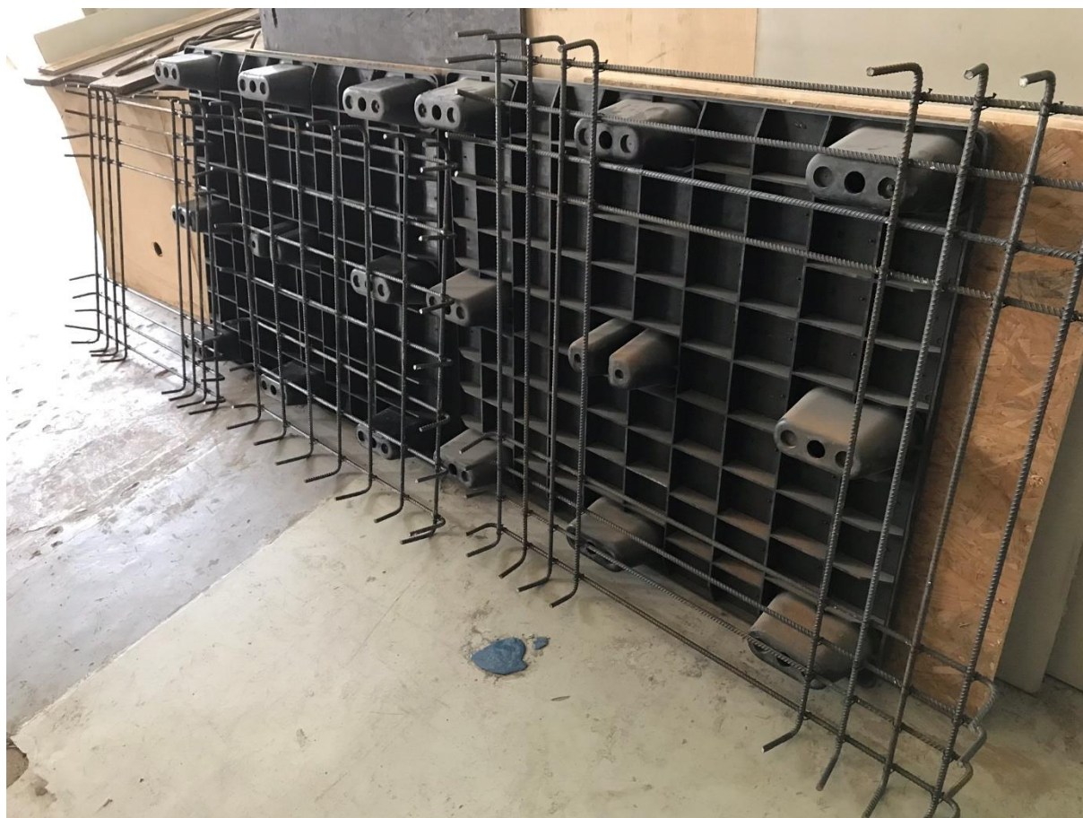
Figura 6.8 - Parte das armaduras do primeiro lote
