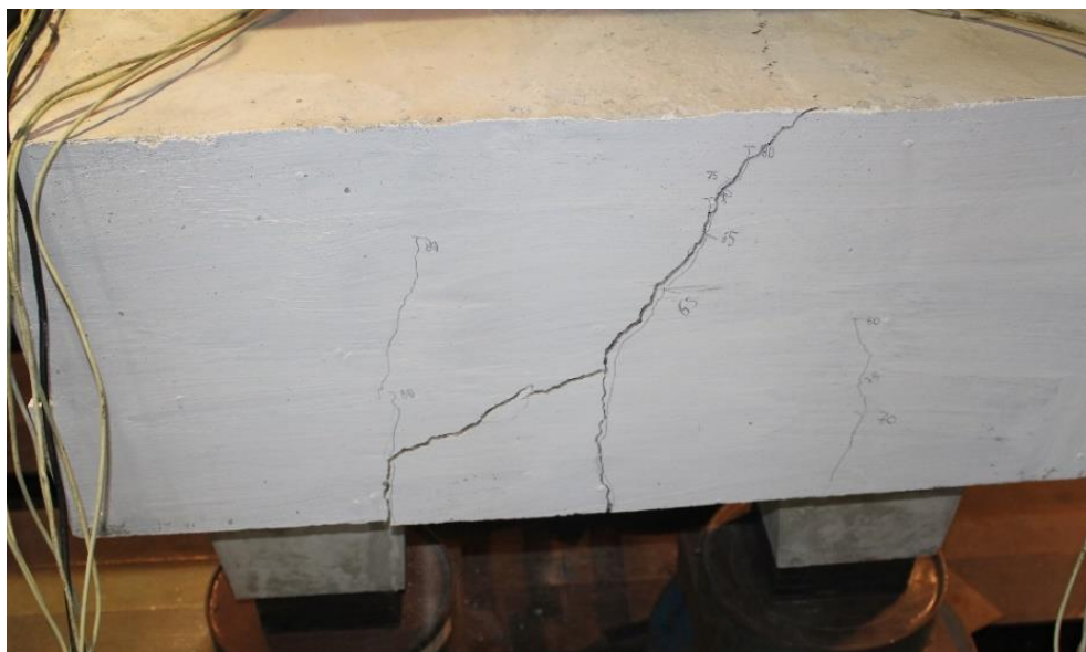
Figura 7.36 - Padrão de fissuração do bloco N2B45A1C após a ruptura
