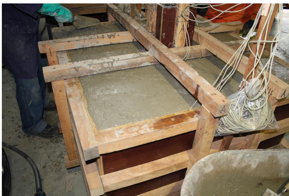
Figura 6.7 - Bloco concretado no dia 09/08/2022
