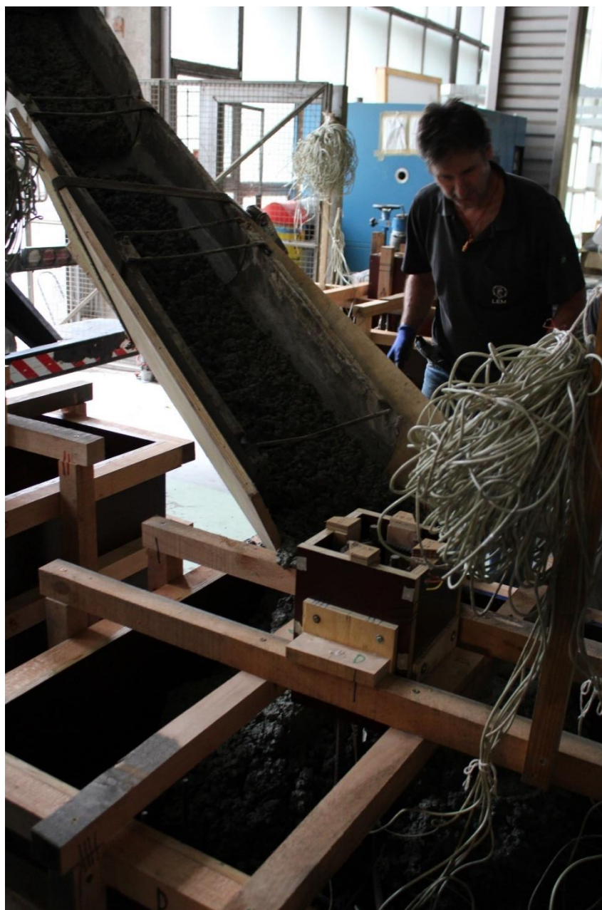
Figura 6.19 - Concretagem dos blocos no dia 20/08/2019
