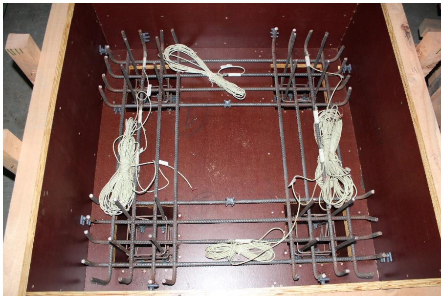
Figura 6.18 - Armadura instrumentada e alojada dentro da forma
