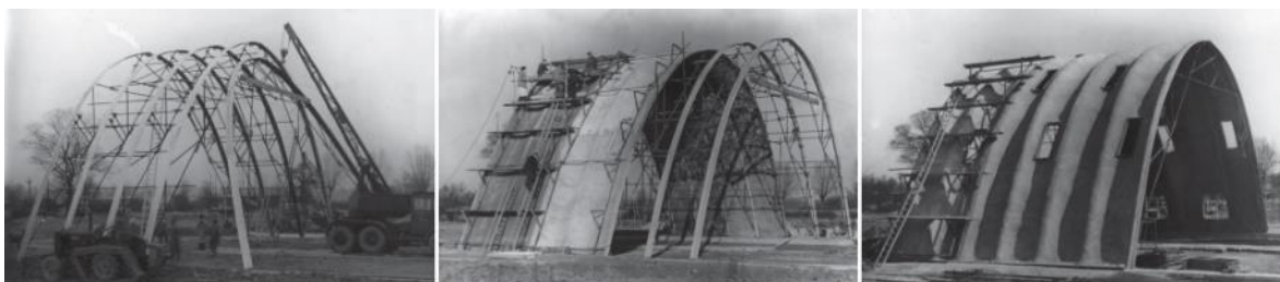
Figura 10 - Construção de uma casca com o sistema "Ctesiphon".
