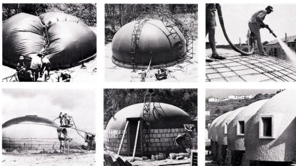
Figura 17 - Etapas construtivas do "Domecrete Building System".
