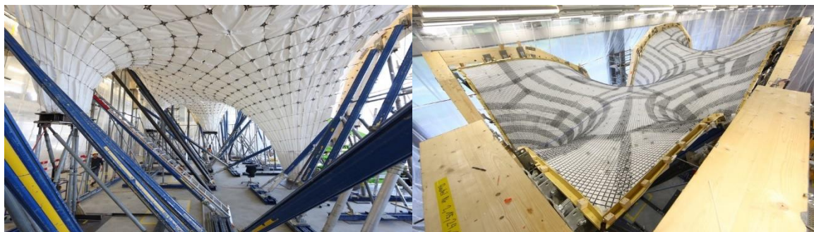
Figura 3 - Protótipo da cobertura do NEST HiLo em execução (2017).
