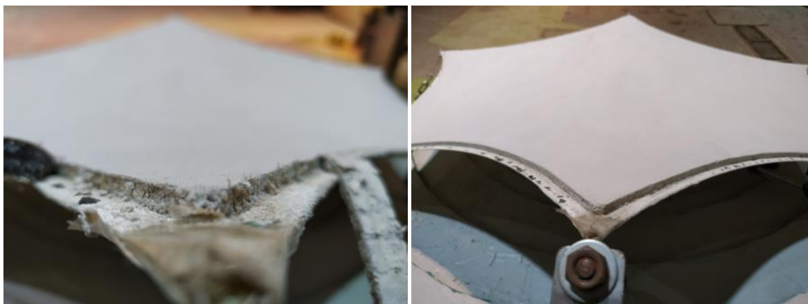
Figura 61 - Remoção dos limitadores localizados nas bordas da casca.
