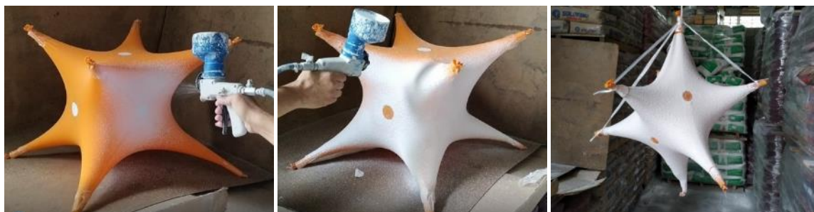
Figura 45 - Projeção da primeira camada sobre o molde tensegrity.
