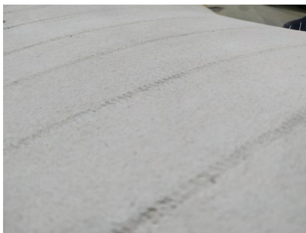
Figura 64 - Superfície inferior da casca em contato com a fôrma.
