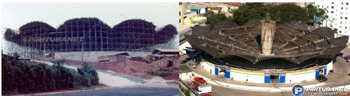
Figura 1 - Mercado de Pirituba, São Paulo/SP (construção entre 1966-1972).
