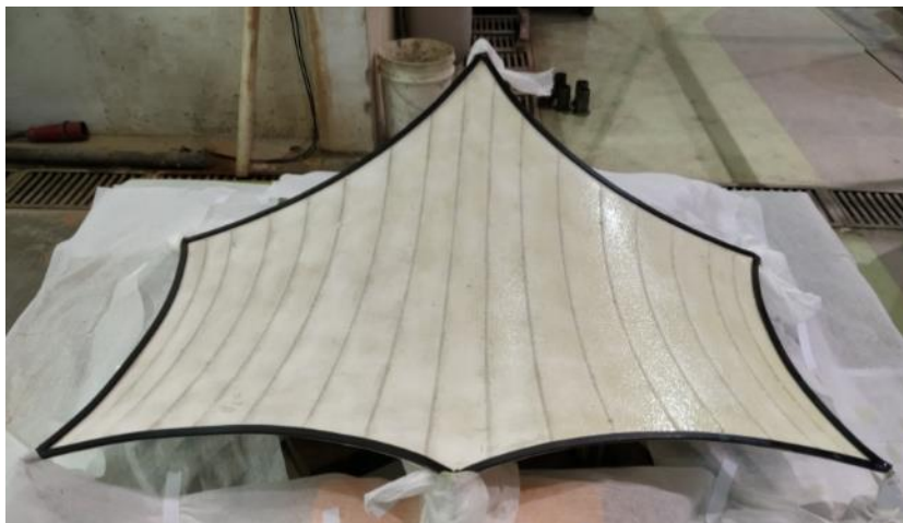
Figura 54 - Membrana pronta para a aplicação da argamassa.
