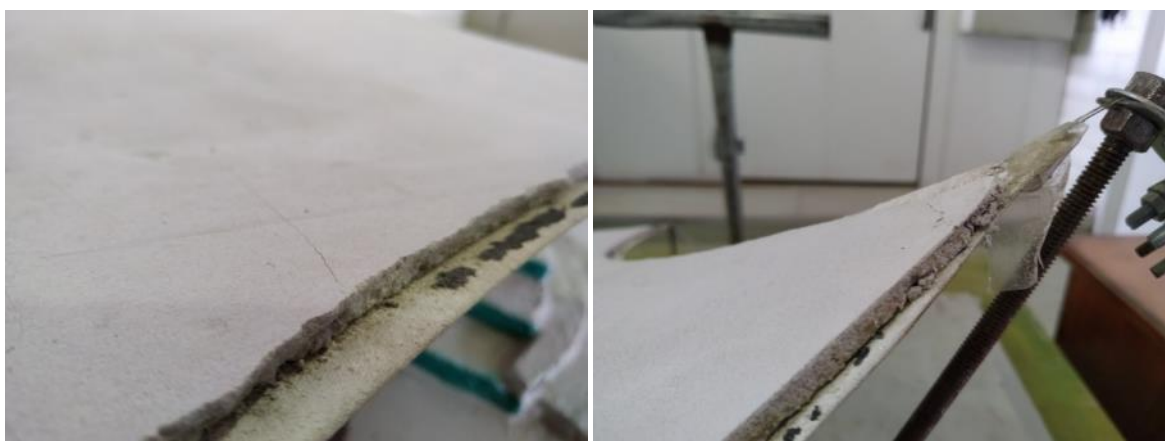
Figura 62 - Surgimento de fissuras na etapa de desmoldagem da casca.
