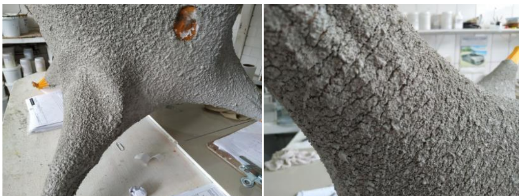
Figura 47 - Enrugamentos do molde e surgimento de fissuras na argamassa.
