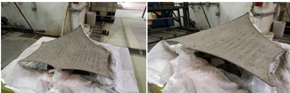
Figura 55 - Aplicação das primeiras camadas de argamassa e colocação do reforço na membrana.
