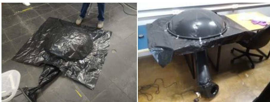
Figura 32 - Entrada inferior para insuflamento da fôrma.
