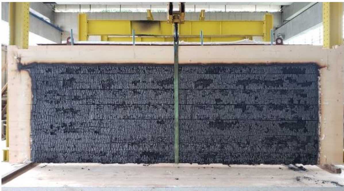
Figura 4.28 - Vista lateral de um painel de CLT após o ensaio.
