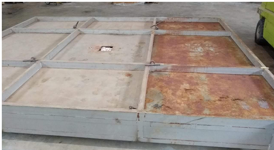
Figura 2.44 – Chapa metálica corroída por um retardante de chamas à base de fósforo.
