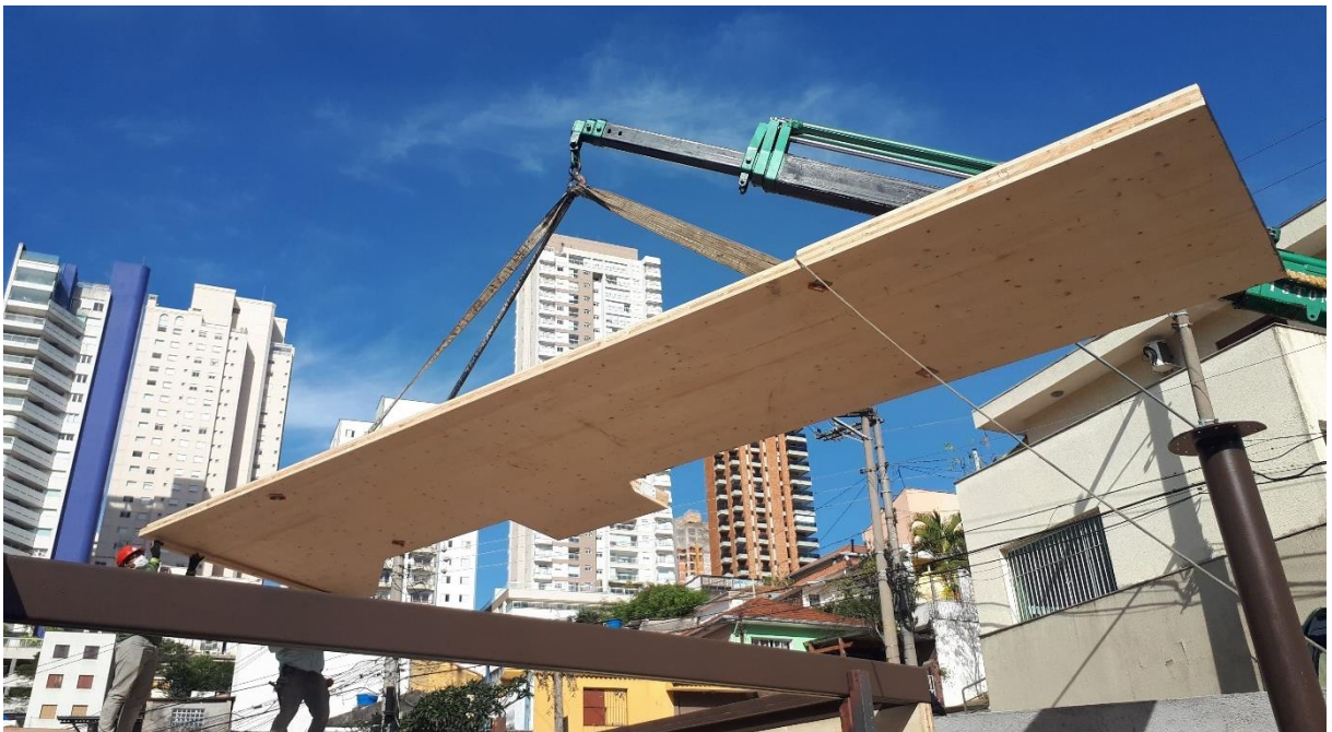
Figura 1.1 - Içamento de uma laje de CLT.
