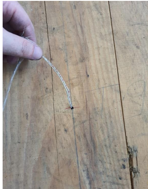
Figura 3.9 - Foto da instalação de um termopar no painel de CLT.
