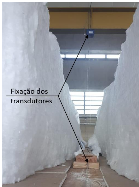
Figura 3.10 - Fixação dos transdutores na laje de CLT.
