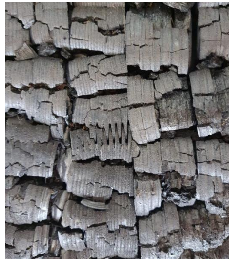
Figura 4.19 - Carbonização nas emendas.
