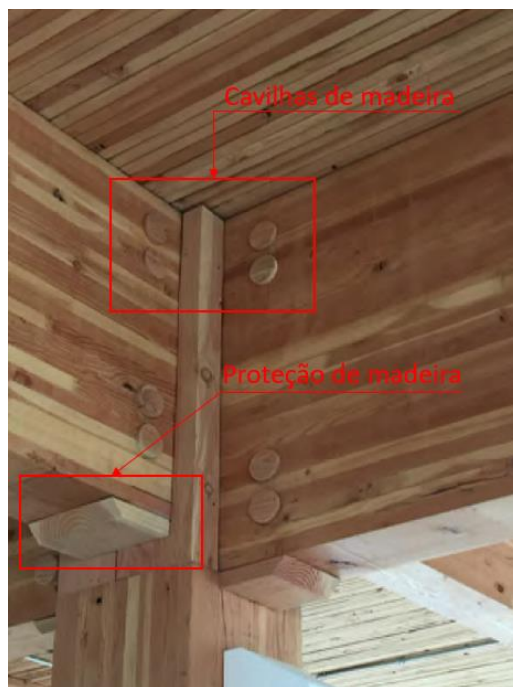
Figura 2.41 – Conexões protegidas com elementos de madeira.
