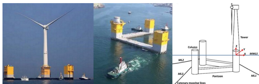
Figura 15 – Plataforma semissubmersível em formato V
